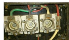
På bilden passerar PEN-ledare genom en delbar nollplint.
